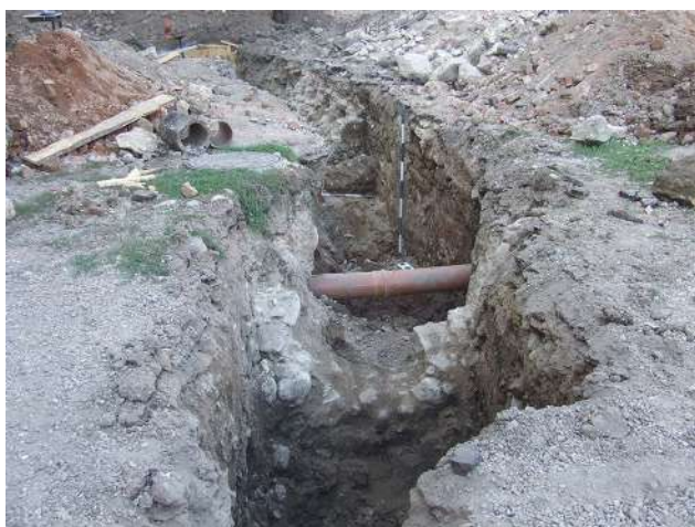
Fig. 24. Detaliu aripa sudică parte demolată Corp C3.
